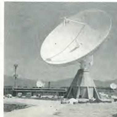
La nuova antenna «C» della stazione «P. Fanti» della Telespazio posta, come le due precedenti, nella conca del Fucino, è stata installata per lavorare con i satelliti «Intelsat» in orbita sopra l'oceano Indiano e consentire così collegamenti con i Paesi dell'oriente.
